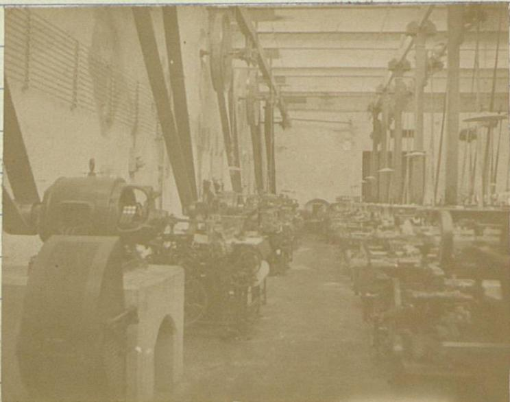
A fábrica nova é movida exclusivamente pela energia eléctrica vindas de Camões e transformada a 220 voltos num transformador de óleo de 150 kilowatts.
