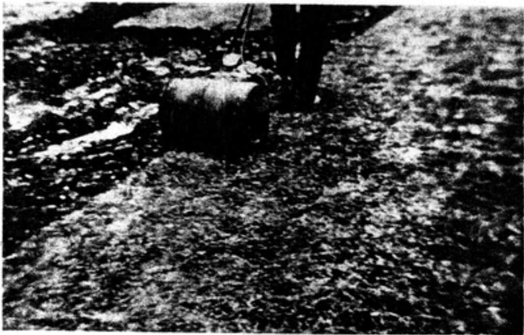
Fig.10 - Passagem de cilindro após homogeneização de um tapete relvado.
