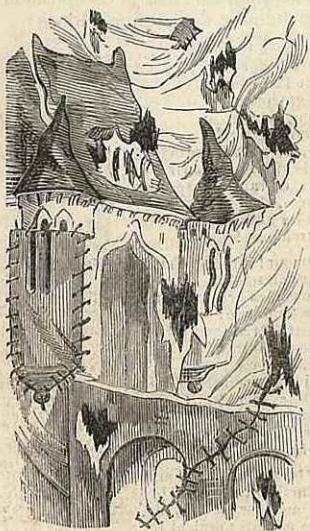
Le château de Chenonceaux, état actuel.
